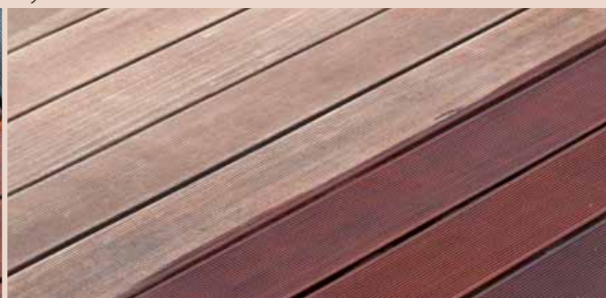
ošetření CC-Bangkirai olej
